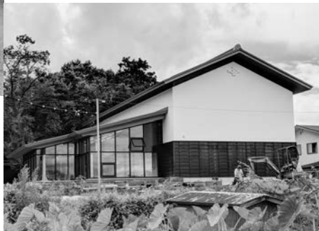
江川文庫収蔵館完成間近の写真
