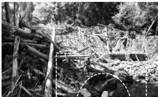
写真① 佐敷トンネル坑口:点線部の坑口と構造物が埋没している
